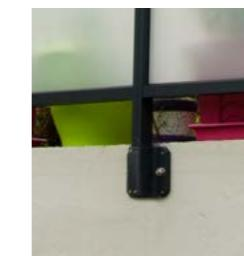
Pose en applique, sur le côté. Ce type de pose est recommandé pour les petits espaces, mais il impose une dalle solide et épaisse.
